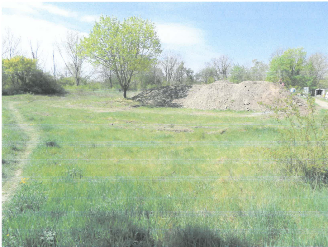
Abb. 3: Begonnene Bauarbeiten im Bereich zwischen Plangebiet und Johann-Wolfgang-von-Goethe-Straße.
